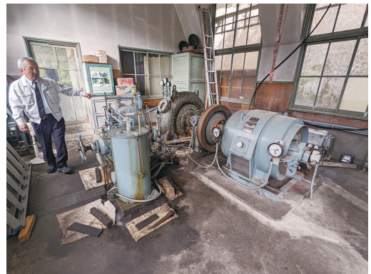
図5 発電機全体像 写真右側から水が注がれる
