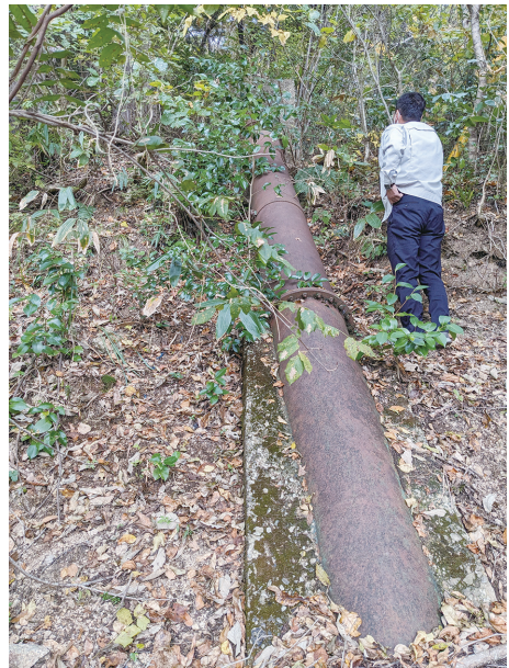
図4 水圧鉄管外観
