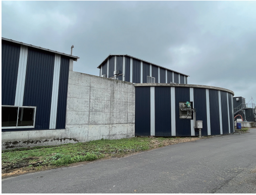
写真6：家畜の排せつ物を発酵させ、メタンガスによる発電を行うバイオガスプラント。みんなの牧場で生産された電気はすべて売電されている。
