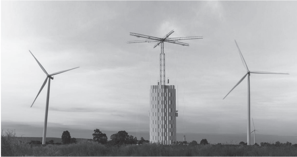
図表 9 風力発電機とともに設置される重力蓄電機（写真中央） 出典：Energy Vault 公式 Facebook より引用。
