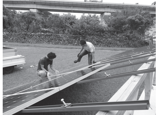
図1：発電施設での作業の様子 (仁木氏提供)
