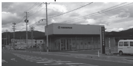
2018年3月に再建された鹿折支店の現在の様子
