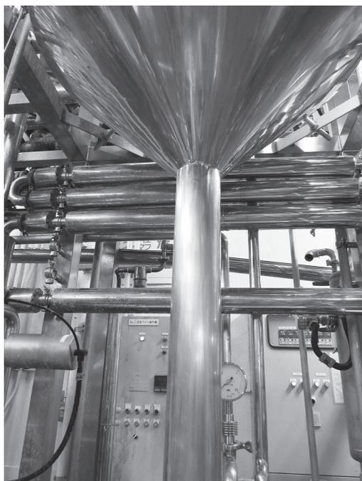
図 1 真空脱気装置
