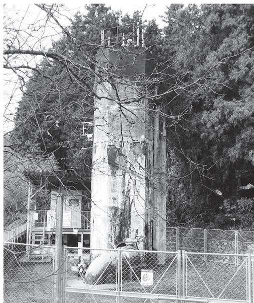
写真7 タワー上部から水を落とす仕組みとなっている
