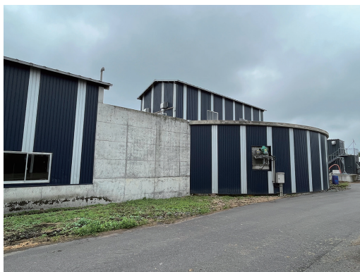
写真6：家畜の排せつ物を発酵させ、メタンガスによる発電を行うバイオガスプラント。みんなの牧場で生産された電気はすべて売電されている。
