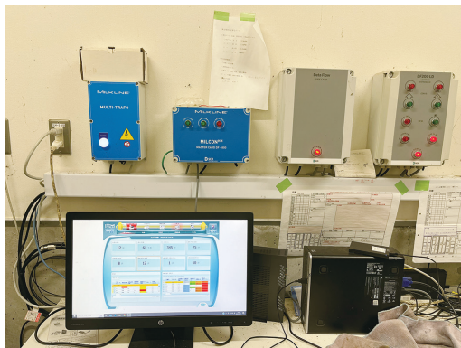
写真 5：ロータリーパーラーと連動し、牛の搾乳状態や乳房炎の兆候などの健康管理を常時チェックしているシステム
