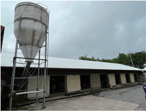
写真3：基礎工事も含め自分たちで建てた牛舎。
