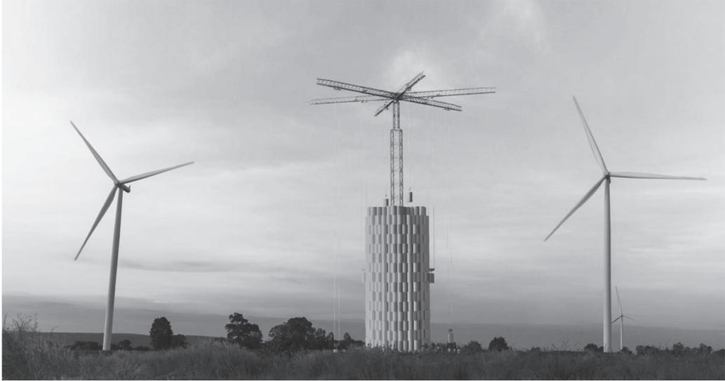
図表9 風力発電機とともに設置される重力蓄電機（写真中央）
