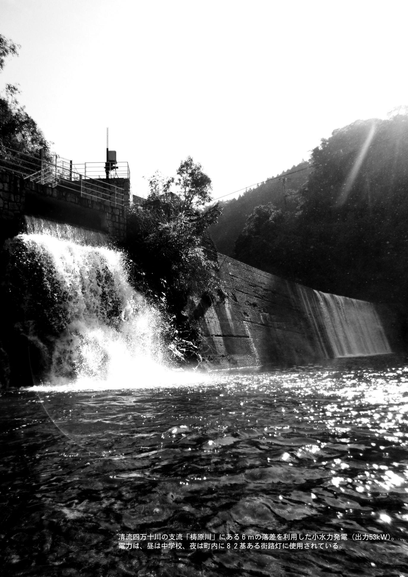
清流四万十川の支流「構原川」にある6mの落差を利用した小水力発電（出力53kW）。
